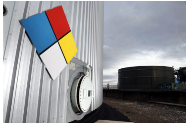
شکل ۱: نمونه‌ای از لوزی خطر نصب شده بر روی یک دستگاه بکار رفته در صنعت [۴]
