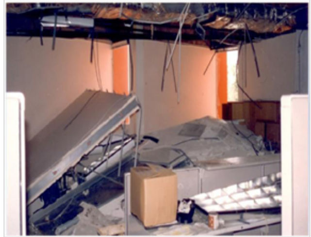
شکل ۱: گسیختگی و فروریزش پانل‌های سقفی و روشنایی، دبیرستان رزدا، زلزله ۱۹۹۴ نورث‌ریج، کالیفرنیا
