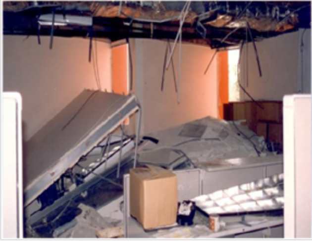
شکل ۱: گسیختگی و فروریزش پانل‌های سقفی و روشنایی، دبیرستان رزدا، زلزله ۱۹۹۴ نورث‌ریج، کالیفرنیا
